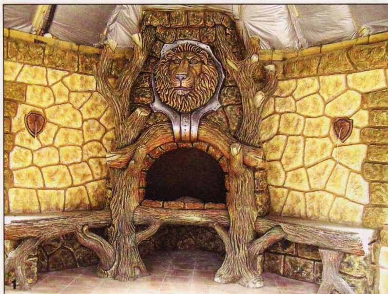
Барбекю в беседке, построенной в Виннице, в охотхозяйстве. Топка выложена кирпичом, воздушная прослойка отделяет её от облицовки.
