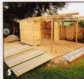
Рис. Обычный строительный комплект состоит из деталей дома с окнами и дверью. Подходящая терраса может быть такой же ширины, как и дом, а может и выступать с обеих сторон, например, по 40 см. Стоит иметь в виду, что значительно проще возводить постройку за один приём, чем к готовому дому потом приставлять террасу.
