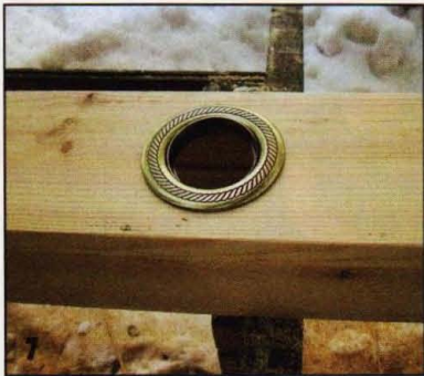
Поочерёдно установили светильники в отверстия короба.
