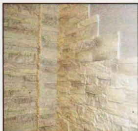
Гипсовая плитка под камень призвана решить проблему быстро загрязняющихся откосов у входной двери и на внешних углах коридора.
