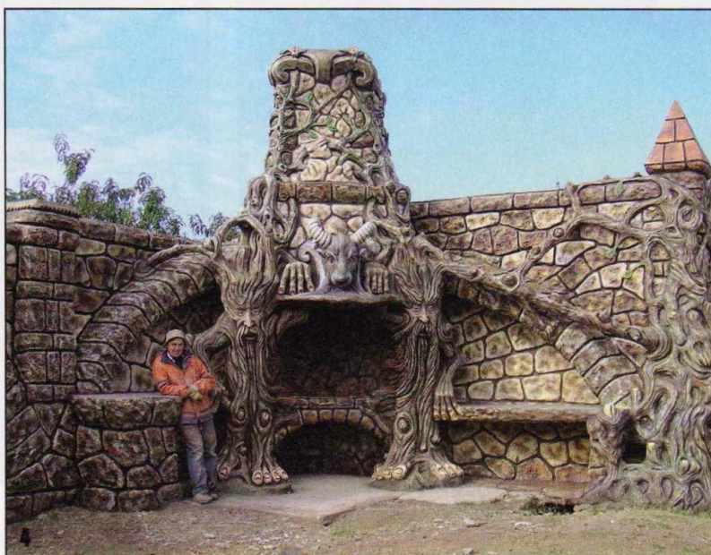
Топка этого садового очага сделана из бетона без футеровки. Такие топки выдерживают длительную (более 20 лет) эксплуатацию без признаков разрушения. Андрей — постоянный член нашей команды.
